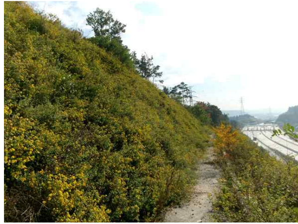
1소단 배수로 전경
