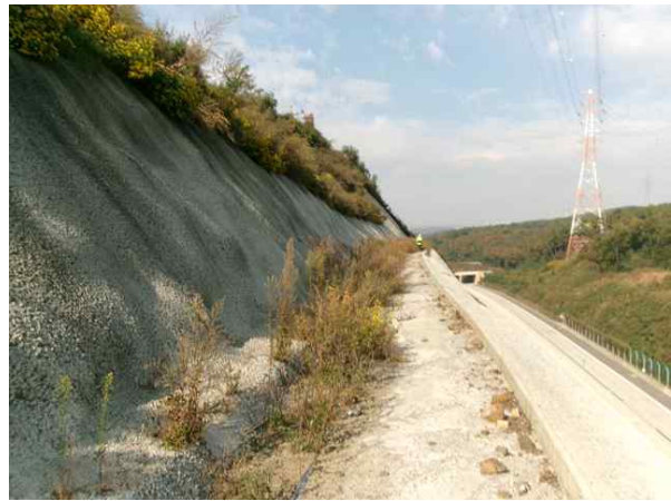
1소단 배수로 전경
